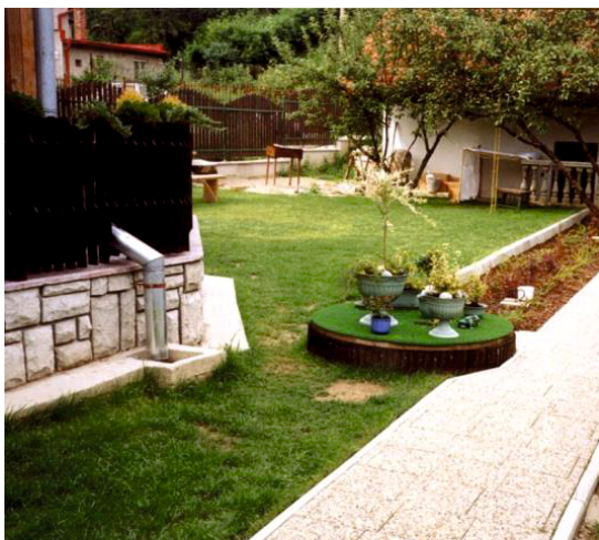
Pohľad na osadenú ČOV pri rod. dome
