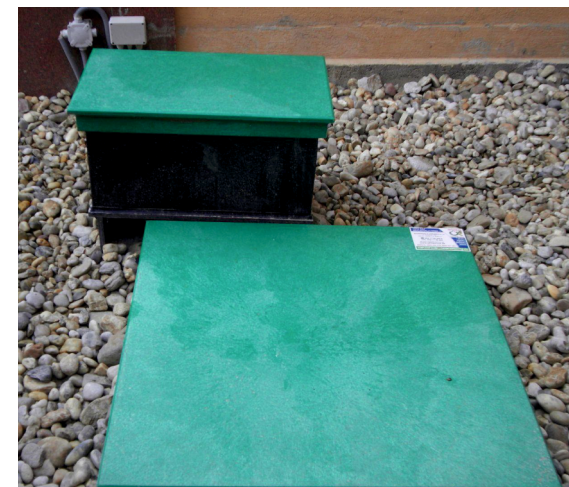
Úprava terénu po montáži
