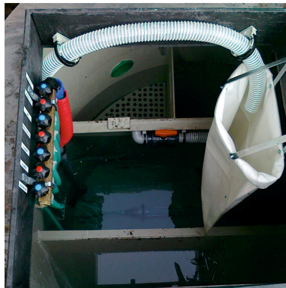
Rozdeľovač vzduchu, nátokový kôš, odvodňovanie kalu
